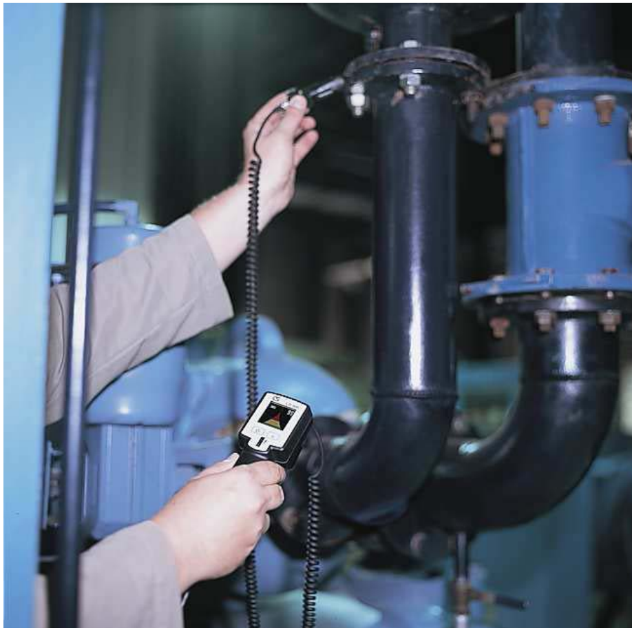
Recherche et identification des fuites
